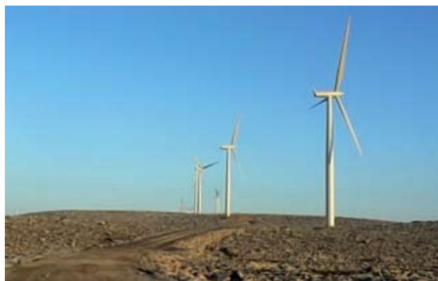
Vindturbinene på Gartefjell. Kilde: Statkraft
